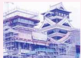
熊本城復旧の様子
