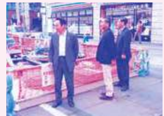
博多駅前陥没場所の様子
